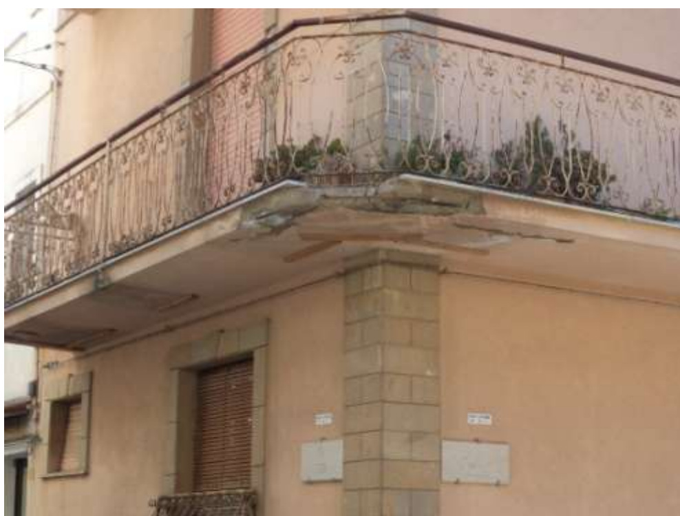
Ballatoio ammalorato di Via Crispi angolo Via Vacirca
